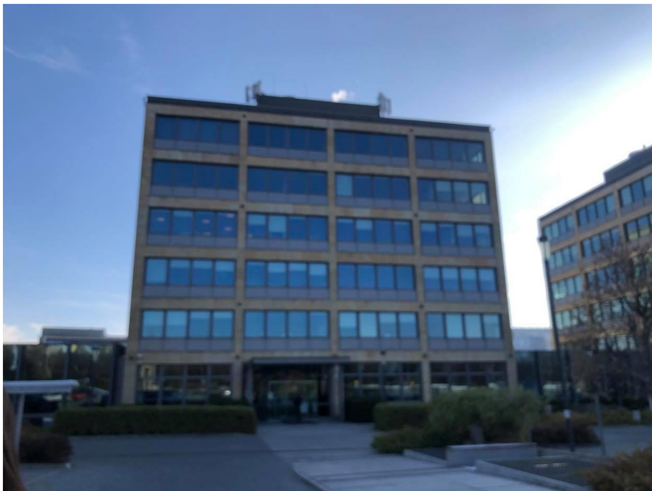
Zaf. nr 1: Widok ogólny instalacji radiokomunikacyjnej.
